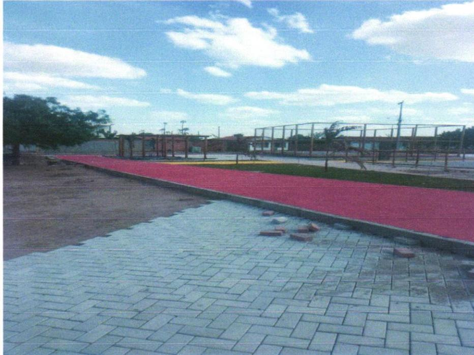
FOTO 07: Pavimentação em bloco de concreto vibroprensado, intertravado, cor natural, 0x20cm, e=6cm, 46un/m<sup>2</sup>, NBR9781, Fck(min)=35MPa, sob coxim areia grossa compactada c/ placa vibratória, e(comp.)=6cm, rejuntado c/ areia fina.
