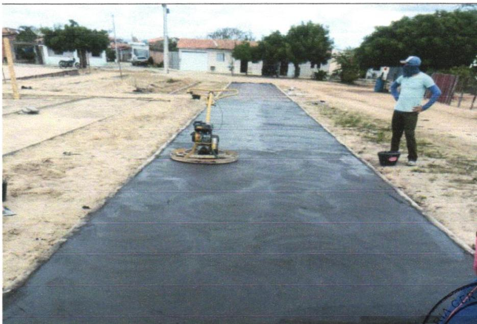
FOTO 08: ACABAMENTO POLIDO PARA PISO DE CONCRETO ARMADO DE ALTA RESISTÊNCIA. AF\_09/2017
