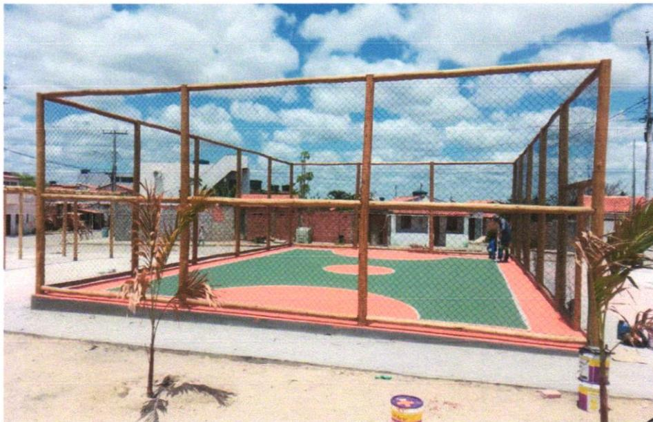
FOTO 06: PINTURA DE PROTEÇÃO SOBRE MADEIRA, COM 02 DEMÃOS, VERNIZ POLISTEN - STAIN, AÇÃO FUNGICIDA E INSETICIDA, COR TRANSPARENTE, SAYERBLACK, QUANTIDADE 100L, SIMILAR
