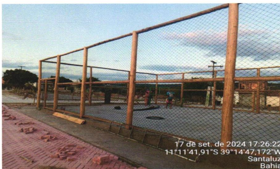
**FOTO 2:** ALAMBRADO PARA QUADRA POLIESPORTIVA, ESTRUTURADO POR TUBOS DE AÇO GALVANIZADO, (MONTANTES COM DIÂMETRO 2", TRAVESSAS E ESCORAS COM DIÂMETRO 1 ¼), COM TELA DE ARAME GALVANIZADO, FIO 10 BWG E MALHA QUADRADA 5X5CM (EXCETO MURETA). AF\_03/202
