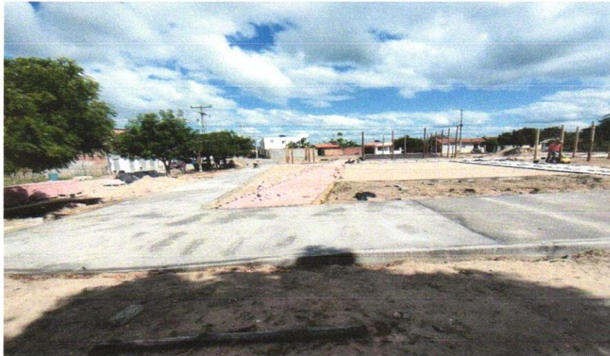
FOTO 03 : ASSENTAMENTO DE GUIA (MEIO-FIO) EM TRECHO RETO, CONFECCIONADA EM CONCRETO PRÉ-FABRICADO, DIMENSÕES 100X15X13X20 CM (COMPRIMENTO X BASE INFERIOR X BASE SUPERIOR X ALTURA), PARA URBANIZAÇÃO INTERNA DE EMPREENDIMENTOS. AF
